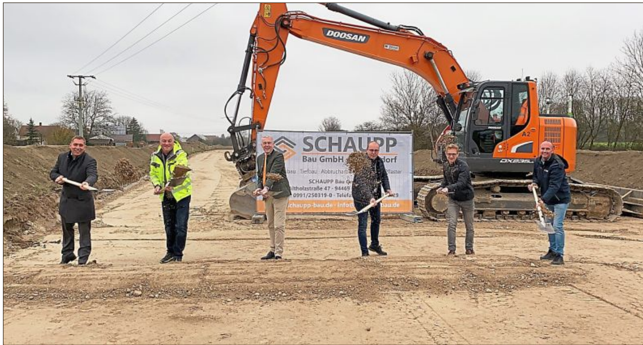
Die Beteiligten freuten sich über den Spatenstich.
